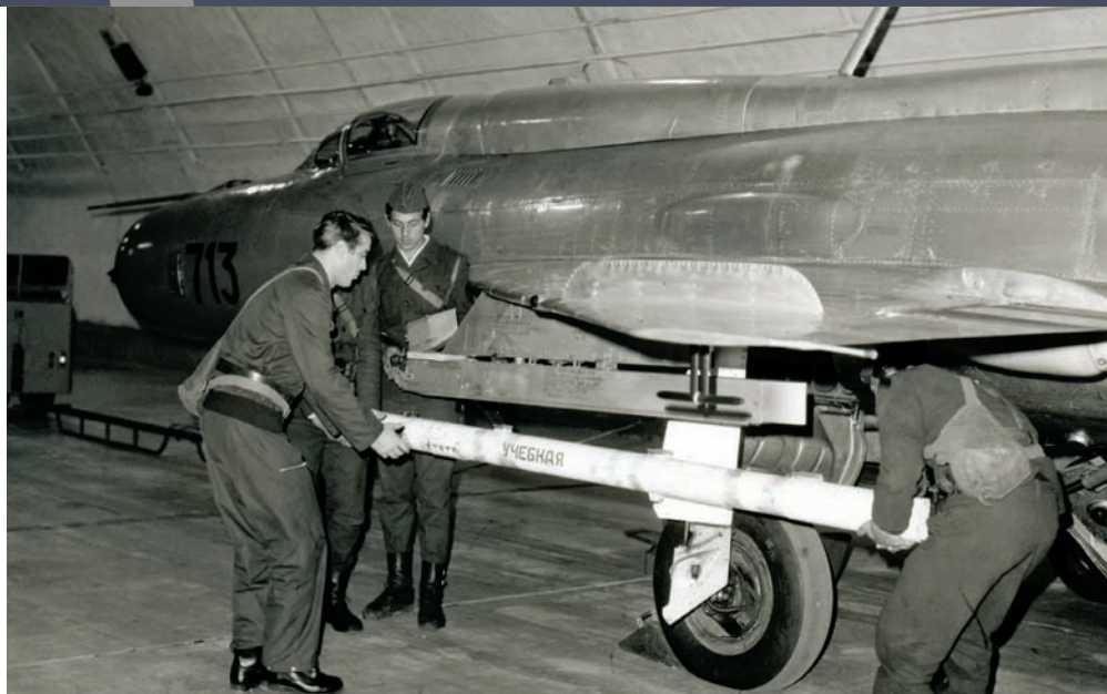
Присвањвање „џисача“ (имишашора ИЦ самонавођене ракете К-13) на ђошкрилни носач МиГ-21ПФМ у 117. пуку 1976. године („Крила армије“)
